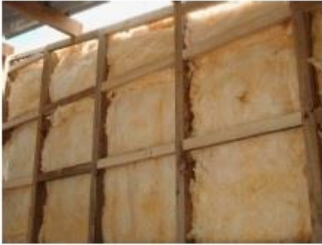
Instalación de fibra de vidrio
