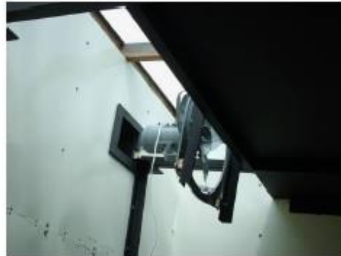
Ubicación e instalación e instalación del ventilador
