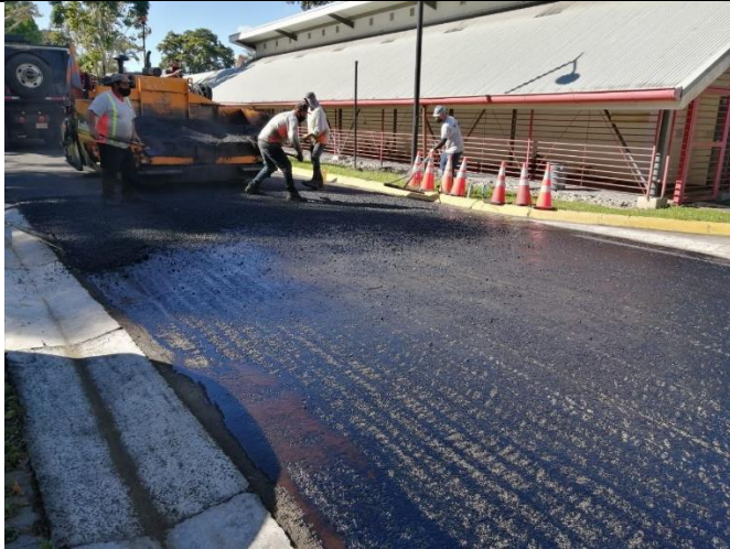
Aplicación de asfalto verde en Instalaciones deportivas
