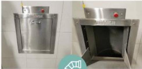
**Shut de basura:** el shut de basura es un ducto por donde se puede trasladar la basura que se genera en cada piso, que va desde el sótano hasta el piso 14. Además, en cada puesto existe un recipiente conectado al mismo ducto, por donde se inyecta líquido para su desinfección.
