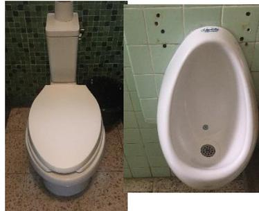
Imagen de servicios sanitarios de bajo consumo instalados en los edificios
