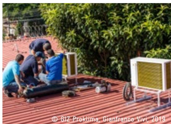
Foto 2. Instalación de unidades de AA con refrigerante R-290 como parte de un entrenamiento en las oficinas de GIZ, Pavas.
