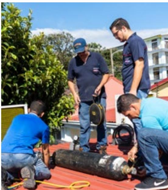
Foto 6. Entrenamiento de instalación de equipo AA tipo split con R-290, GIZ, Pavas.
