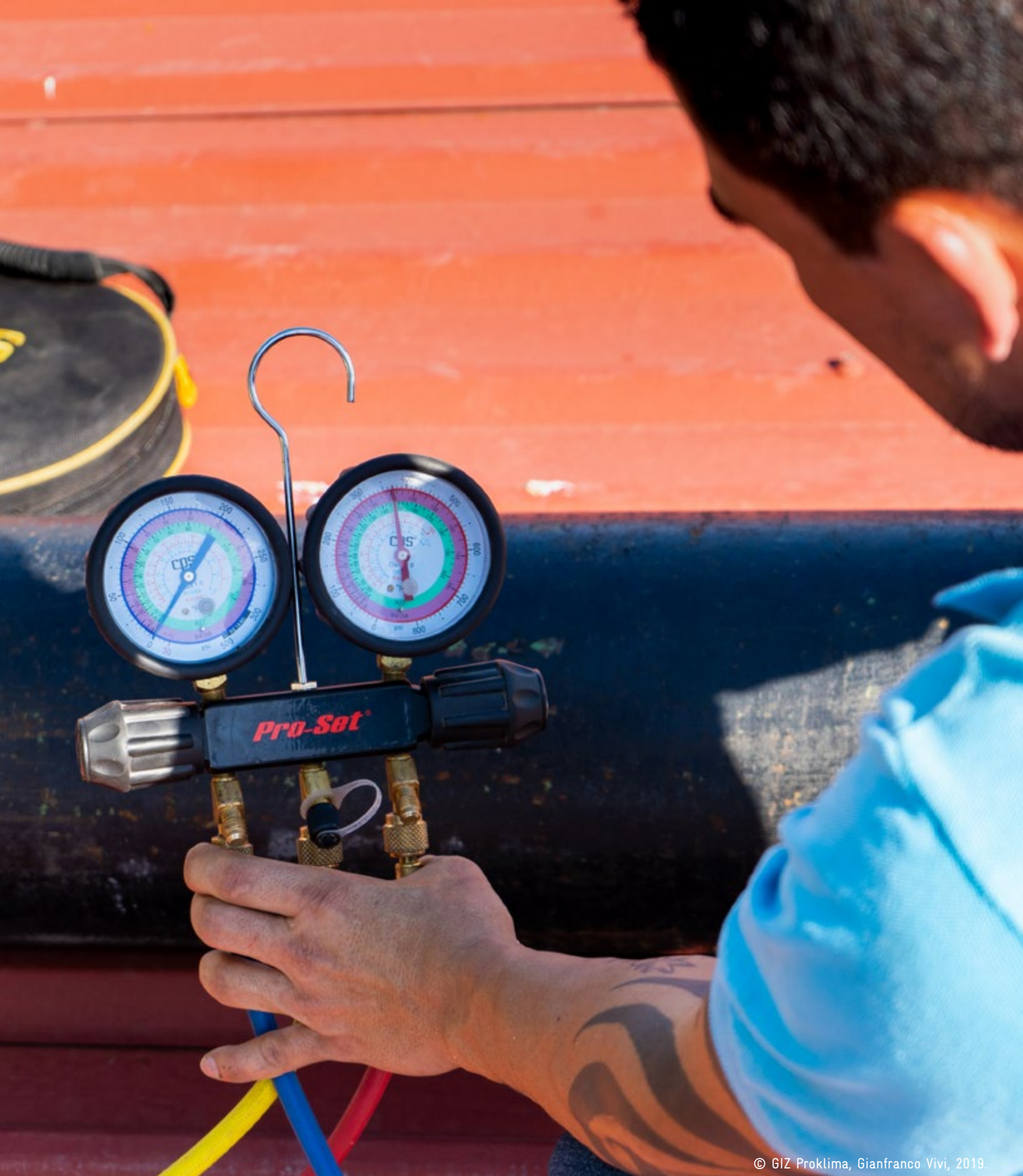
Foto 1. Uso de manómetro en la instalación de un equipo de AA tipo split.
