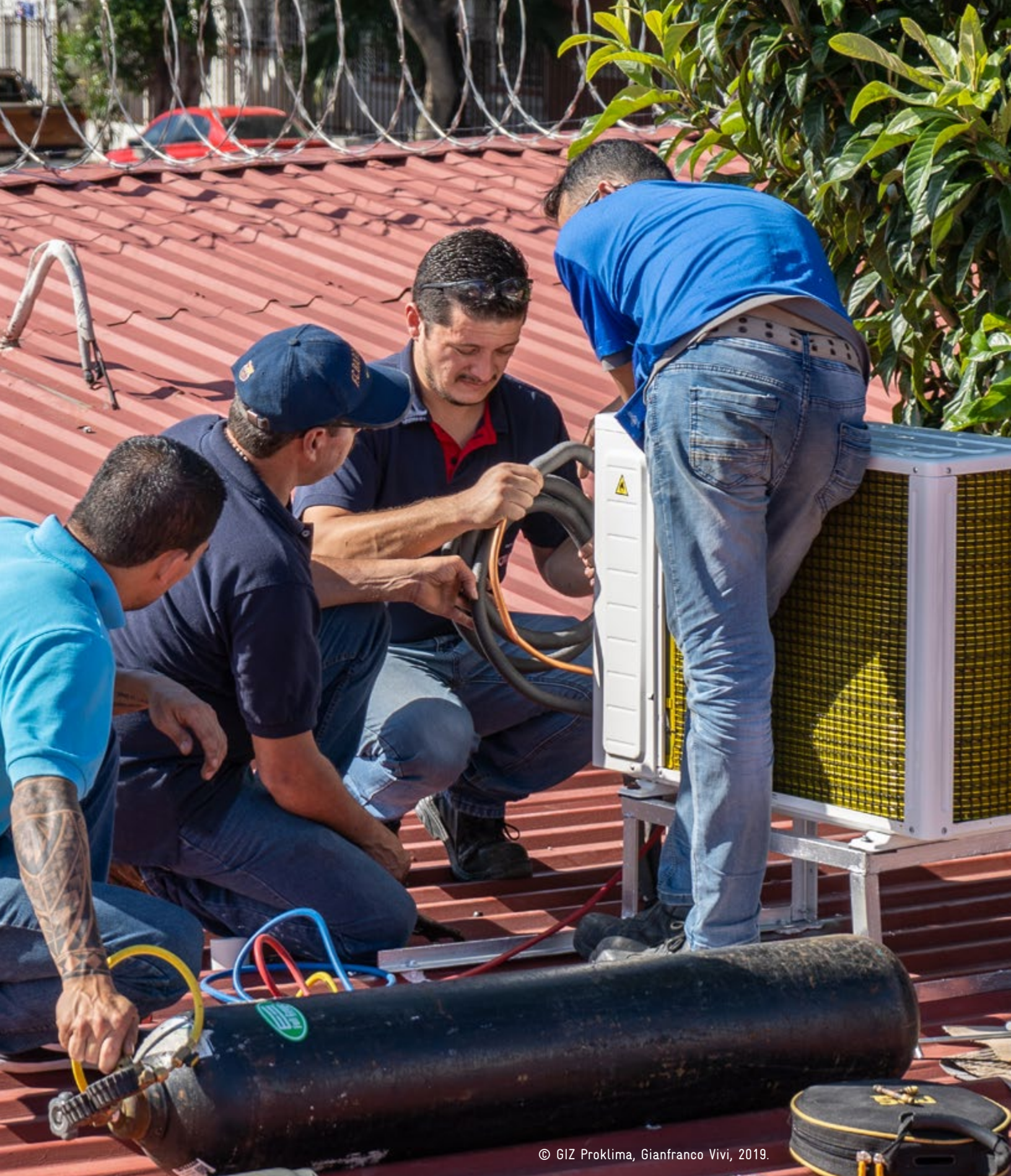
Foto 6. Carga de refrigerante en equipo de AA tipo split.
