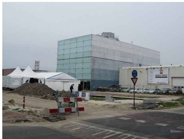
Gráfico 34:: Central de frío de Ámsterdam, en situación periurbana
