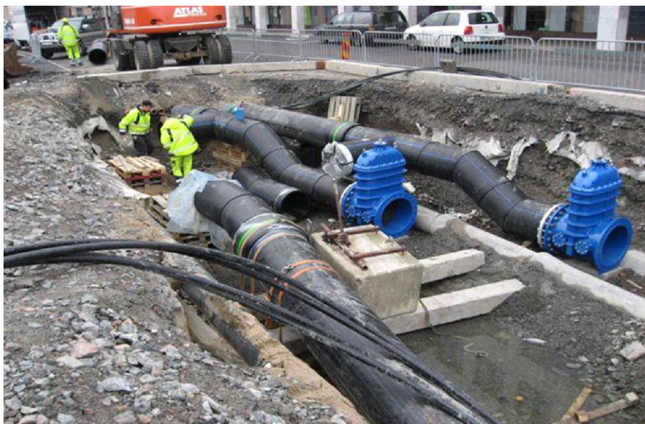
Gráfico 39: Construcción de tuberías de distribución preaisladas
